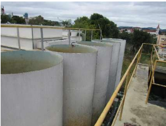
Filtros módulo metálico e filtros módulo em concreto
