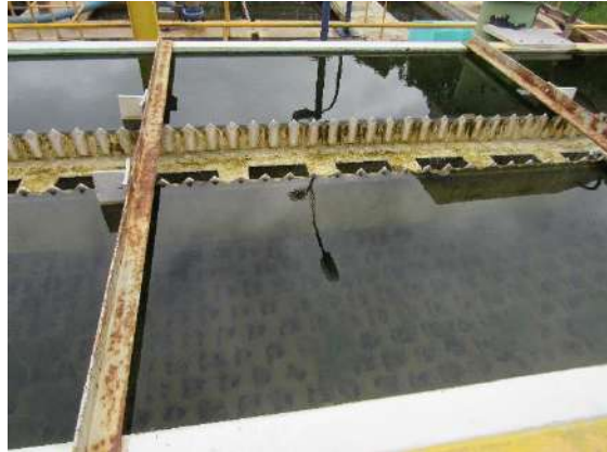
Floculadores e Decantadores do módulo metálico
