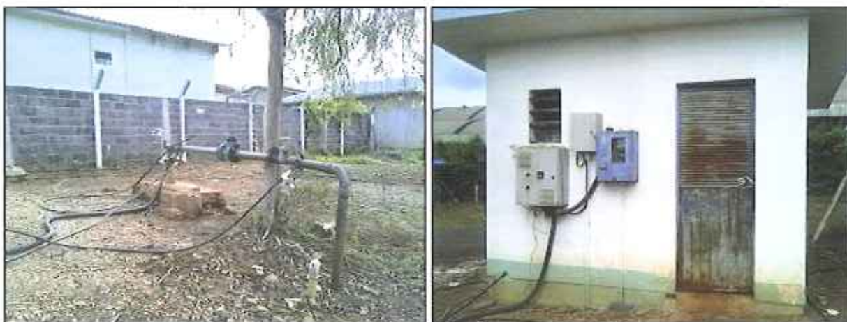
Figura 3: Poço Rio das Pedras I e casa de química
