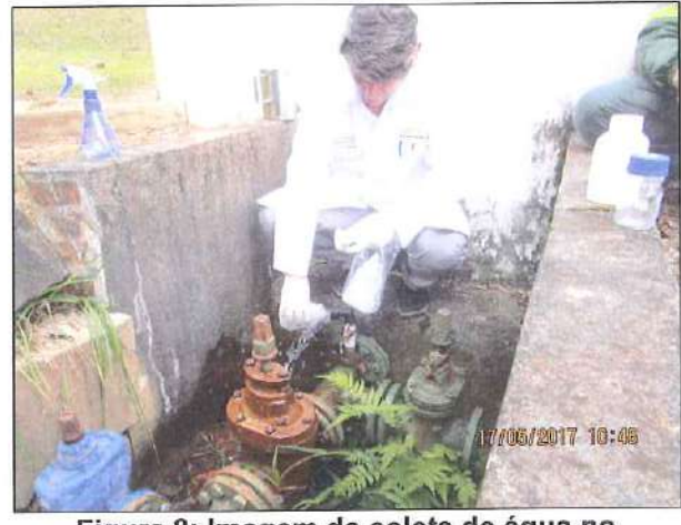
Figura 8: Imagem da coleta de água no Reservatório R6.
