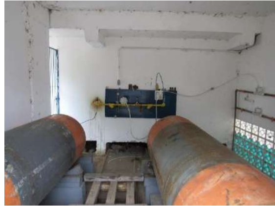
Tanque reservatório de Polímero e dosagem de Cloro
