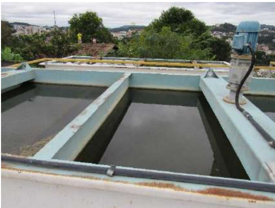
Floculadores e Decantadores do módulo metálico
