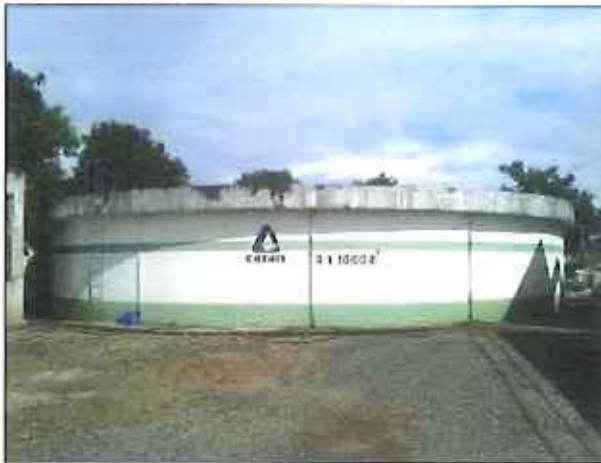
Figura 7: Reservatório R01, no terreno da ETA – 1000 m 3
