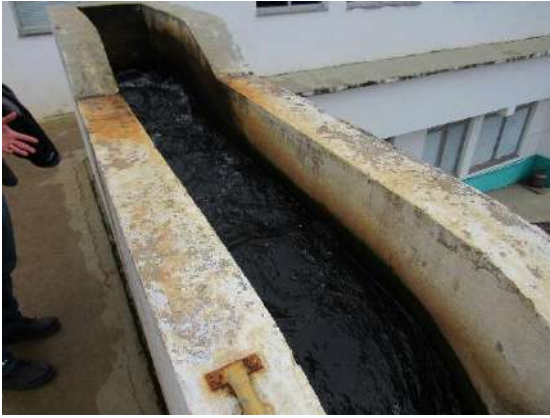
Entrada de Água e Floculadores do módulo em Concreto
