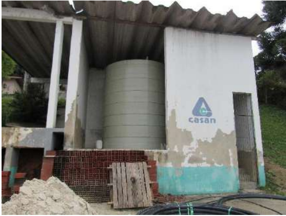
Tanque reservatório de Polímero e dosagem de Cloro
