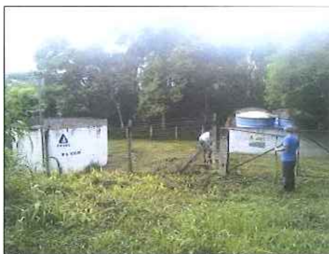
Figura 29: Reservatórios R06 – 100 m 3 + 25 m 3 cada
