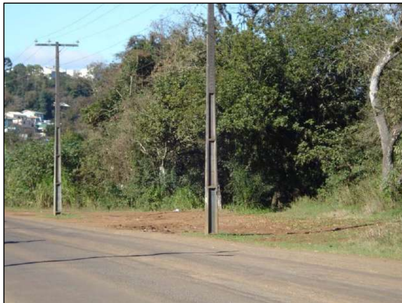
Figura 4 - Local da elevatória EE-09
