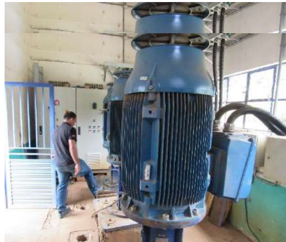
Bombas de Eixo Vertical
