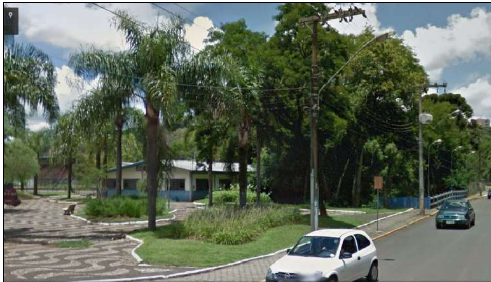
Figura 07 - Local da elevatória EE-14
