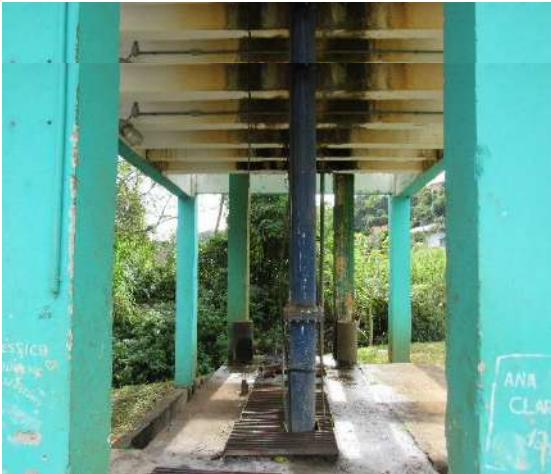
Bombas de Eixo Vertical
