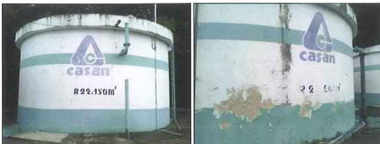
Figura 17: Reservatório R02.2A e R02.2B – 150 m 3 e 200 m 3 , respectivamente
