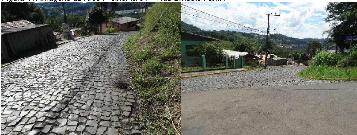
Figura 44: Imagens da Área Problema 01 – Rua Ernesto Fantin
