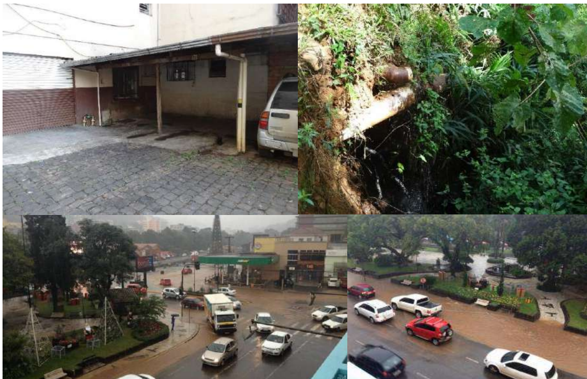
Figura 48: Imagens da Área Problema 03 – Córrego do Curtume (Córrego Sanga)
