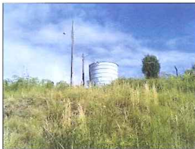
Figura 24: Reservatório R04.3 – 20 m³
