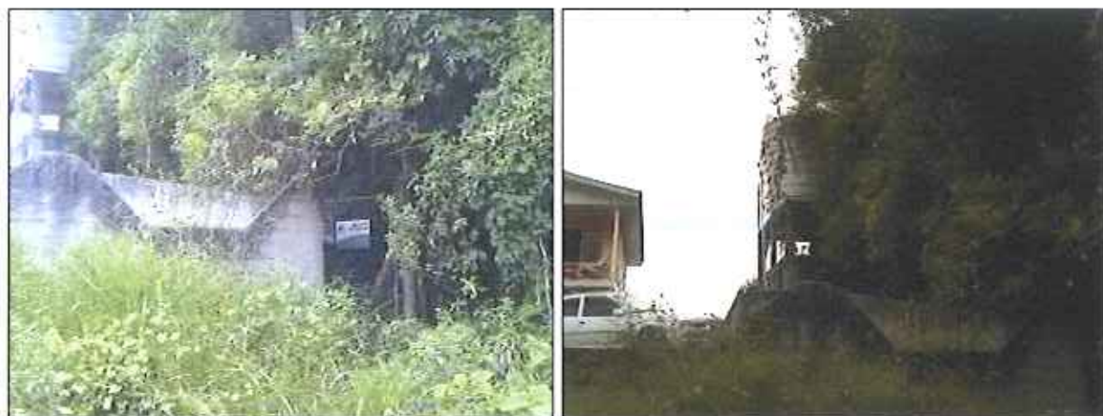
Figura 12: Reservatório R01.5 – 20 m 3
